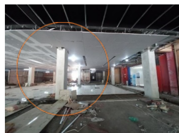
Gambar 6. Kolom Bangunan (Sumber: Google Images, 2023)
