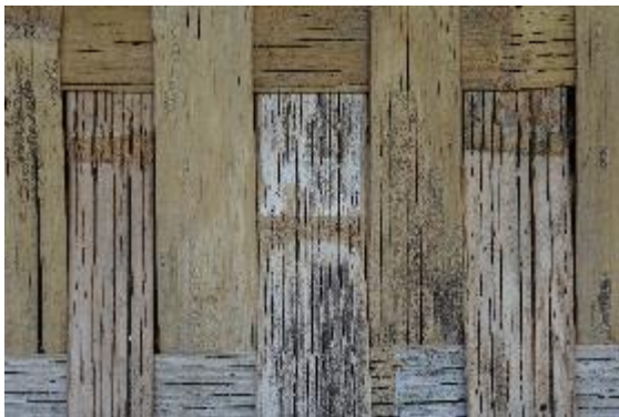
Gambar 1. 21 Bambu sebagai dinding bangunan 2
