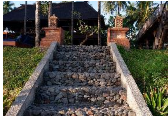
Gambar 1. 11 Penerapan batu kali pada tangga dengan perekat semen
