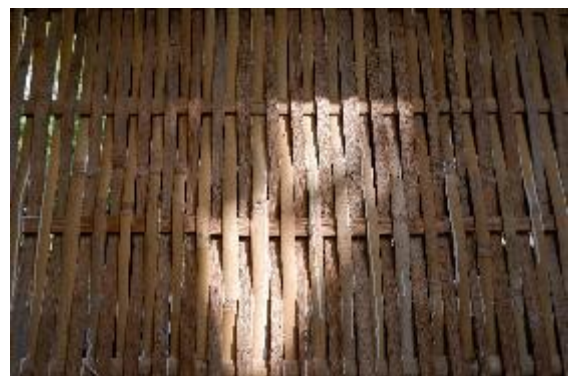
Gambar 1. 20 Bambu sebagai bagian dinding bangunan
