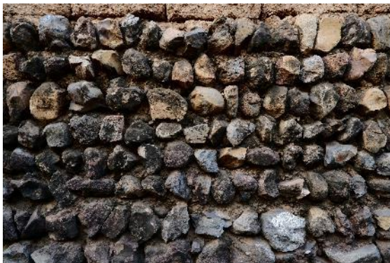
Gambar 1. 10 Penerapan batu kali pada dinding dengan perekat tanah liat
