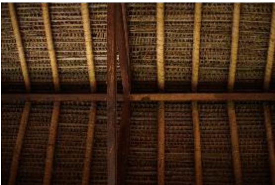
Gambar 1. 14 Penerapan daun kelapa pada atap tampak bagian dalam
