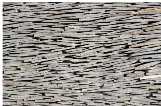
Gambar 1. 7 Penerapan batu rejeng pada dinding
