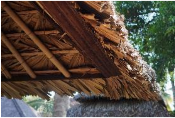
Gambar 1. 17 Penerapan daun lontar sebagai material penutup atap
