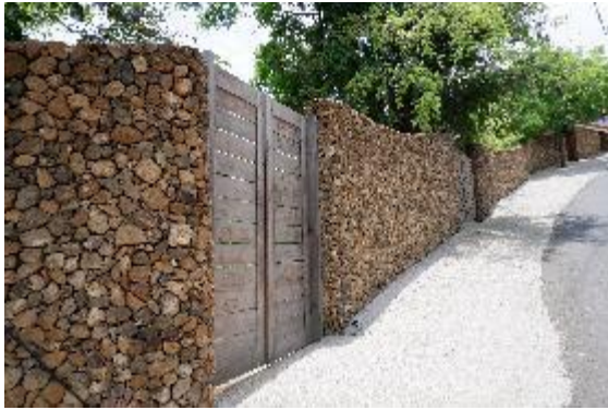
Gambar 1. 8 Penerapan batu kuning pada dinding pagar
