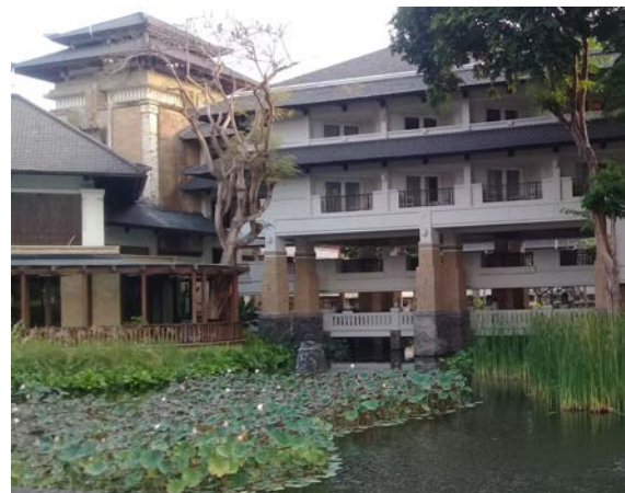
Gambar 19 Kolam Alami yang Menghubungkan setiap Bangunan (Sumber: Arimbawa, 2019)
