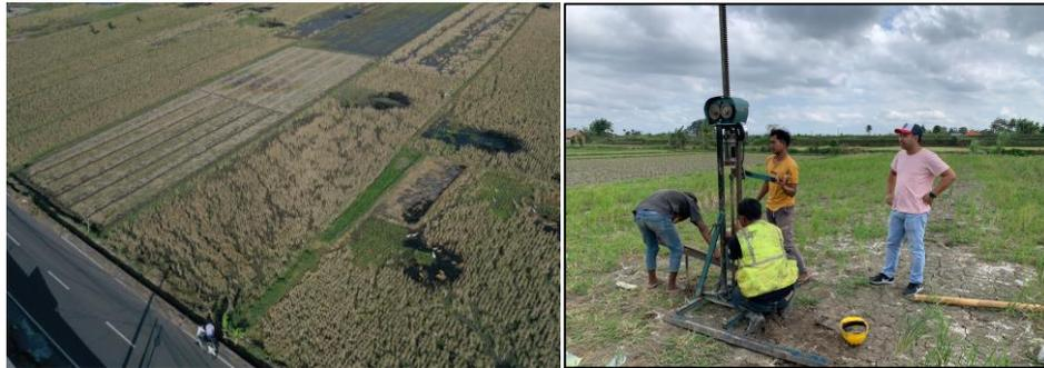
**Gambar 4.** Foto Kondisi Lahan dan Proses Tes Sondir Tanah
