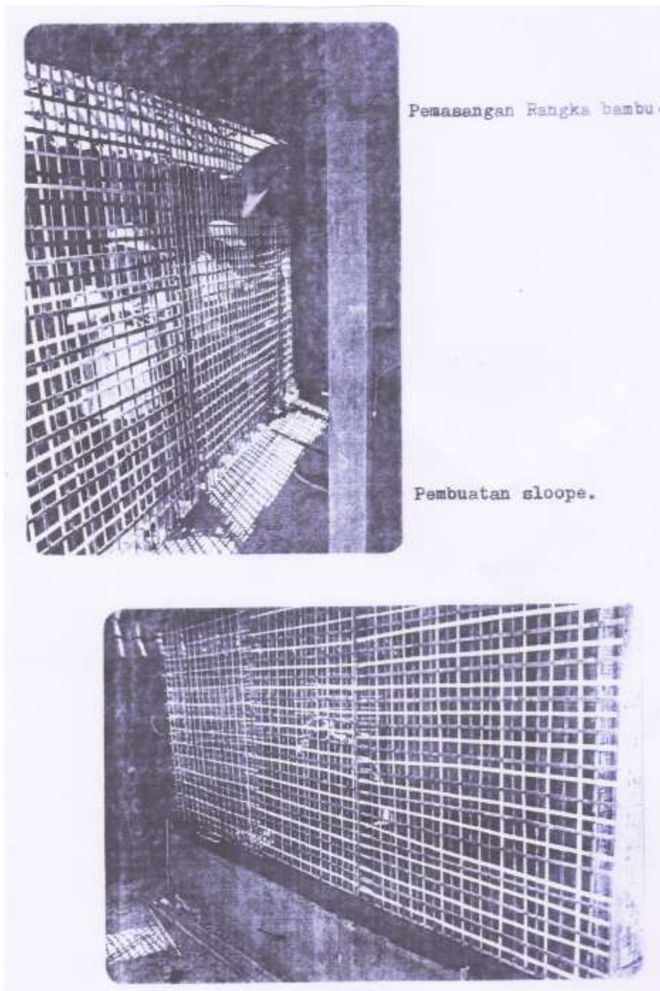
Gambar 5. Foto Pemasangan Rangka Bambu
