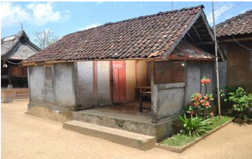
Gambar 8. Kondisi Bangunan Dinding Bambu Semen tahun 2014
