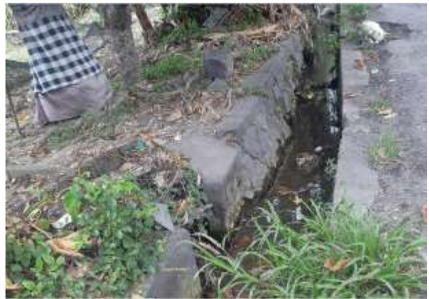
(Kondisi lining saluran)
