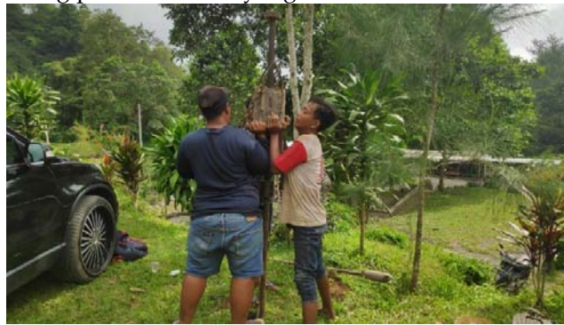
Gambar 8 Proses pelaksanaan boring dan uji SPT
