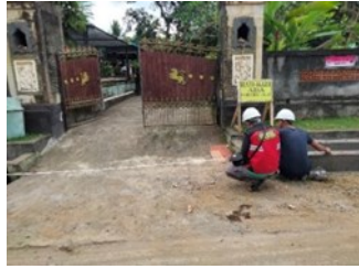
Gambar 5. Pengukuran pelebaran jalan
