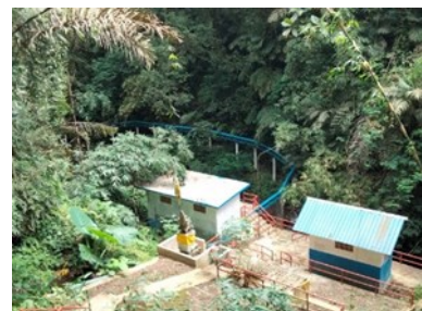
Gambar 4. Pemasangan Pipa dengan titik-titik
