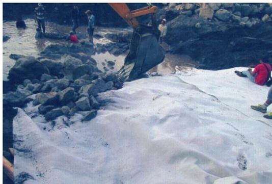
**Gambar 3. Pemasangan lapisan inti dengan bantuan excavator.**
